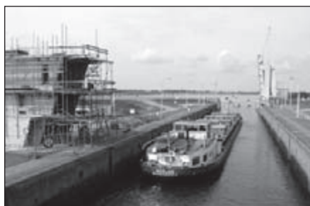
Sluis in de Zandkreekdijk
